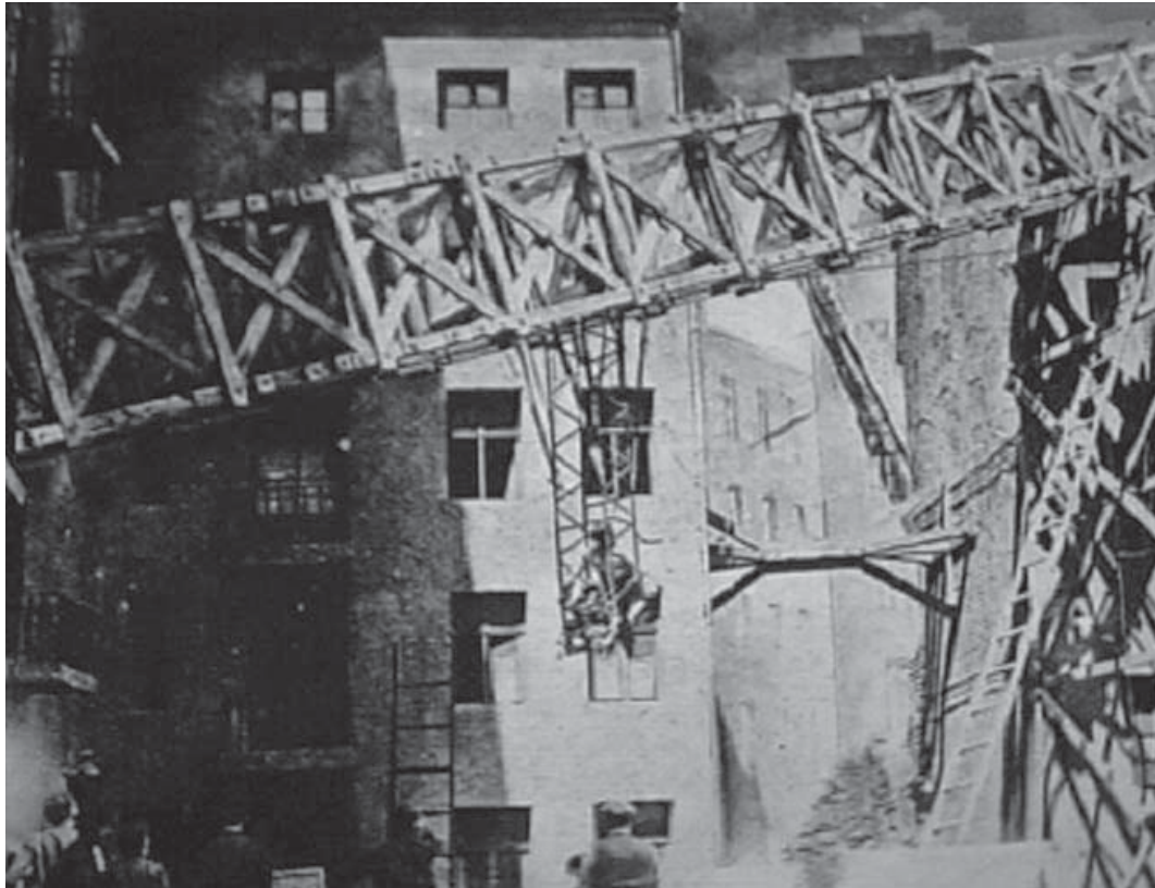
Der Kran bei den Dreharbeiten von Friedrich Wilhelm Murnaus DER LETZTE MANN
